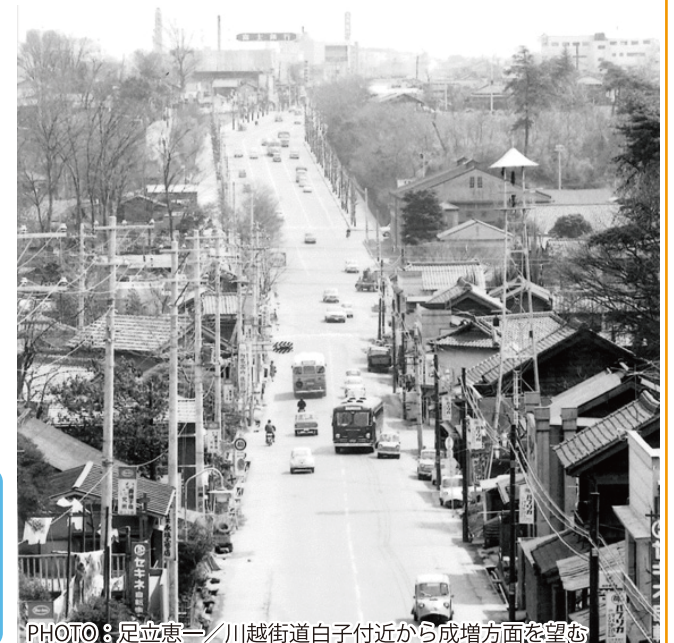
PHOTO: 足立恵一/川越街道白子付近から成増方面を望む
